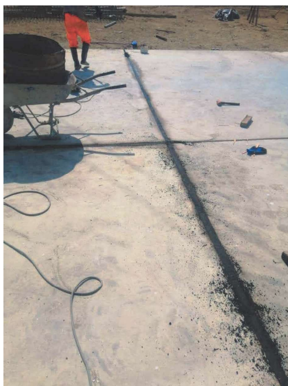
COLOCACION DE JUNTAS DE DILATACION
