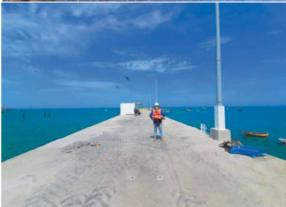
PANORAMA GENERAL DE OBRA CULMINADA AL 100%
