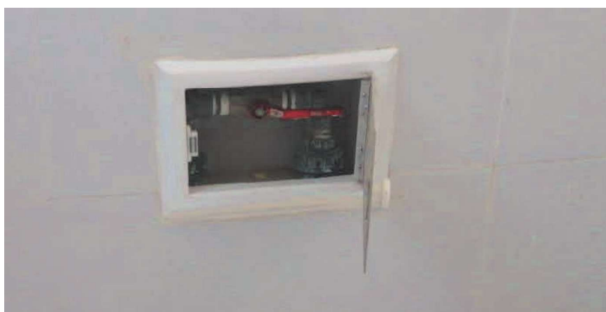
CAJA PARA VALVULAS CON MARCO Y TAPA FIBRA DE VIDRIO INC. TIRADOR DE BRONCE
