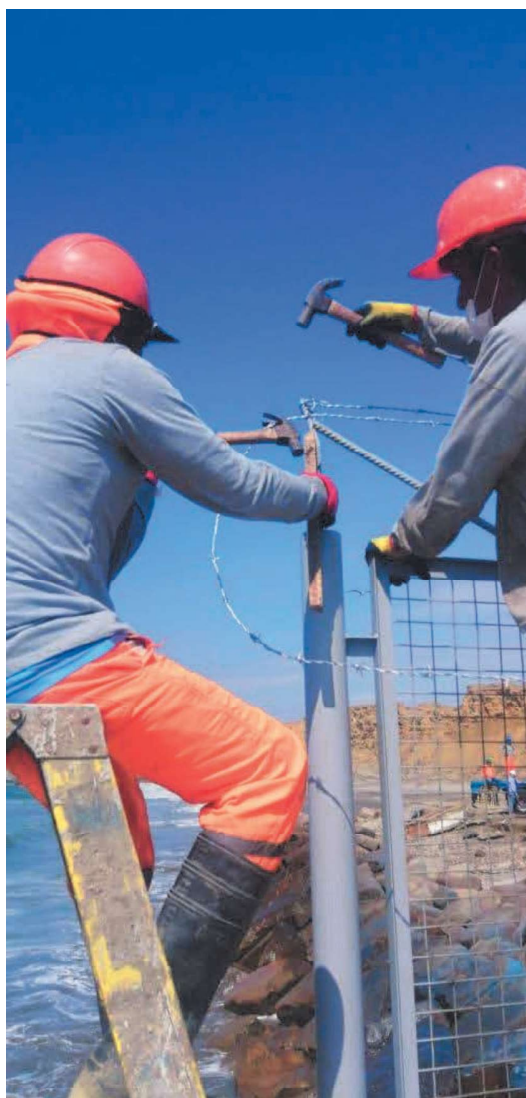
COLOCACIÓN DE PÚAS EN CERCO DE MALLA
