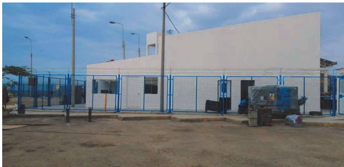
PINTURA EPOXICA 2 MANOS EN MUROS EXTERIORES
