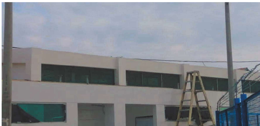
SOMBREROS DE VENTILACIÓN
