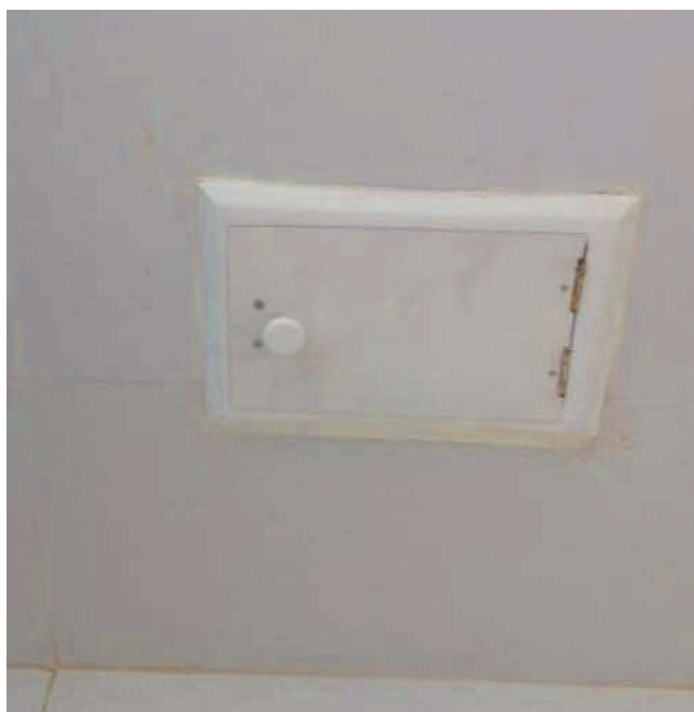
CAJA PARA VALVULAS CON MARCO Y TAPA FIBRA DE VIDRIO INC. TIRADOR DE BRONCE
