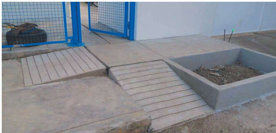
RAMPA Y SARDINEL DE INGRESO
