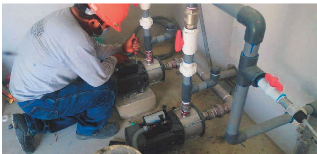
INSTALACIÓN Y PUESTA EN SERVICIO DE BOMBAS DE AGUA SALADA
